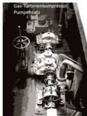
Gas-Turbinenkompressor, offenes Unterteil
